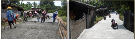
ก่อสร้างถนน คสล.(ซอยบ้านนายประชา ทองจันทร์) หมู่ ๓ บ้านตำหรุใน
