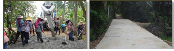
ก่อสร้างถนน คสล. (เลียบบห้วยกระชาย) หมู่ ๒ บ้านระหารน้อย
