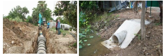
ฝังท่อระบายน้ำ(บริเวณบ้านนายถนอม วงเพชร)
