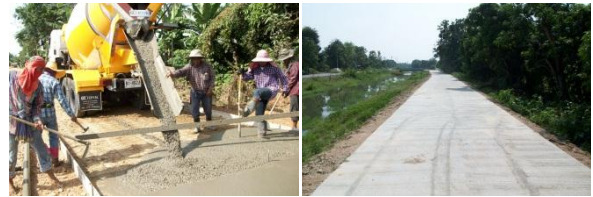
ก่อสร้างถนน คสล. (เลียบบคลองชลประทาน) หมู่ ๔ บ้านตำหรุ
